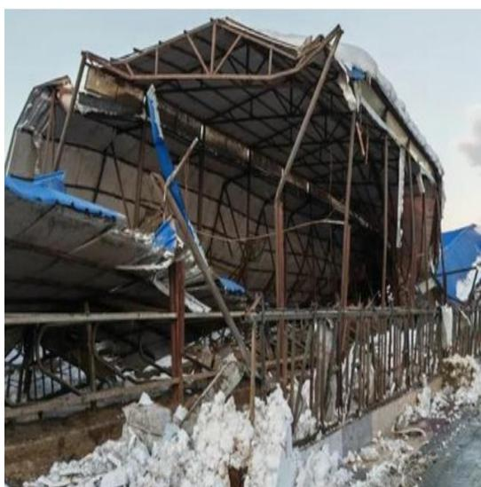
图 1-5 暴雪倒塌后的牛舍
